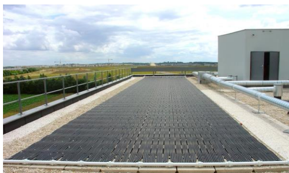
Pose en toiture terrasse sur parpaings
