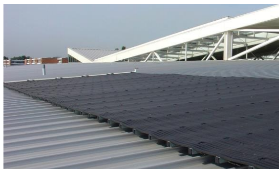
Pose sur toiture zinc avec châssis métallique
