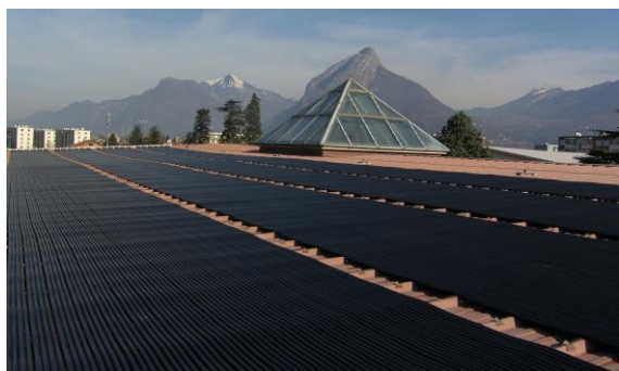
Pose directe sur toiture bac acier
