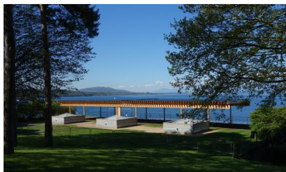
Pose sur pergola
