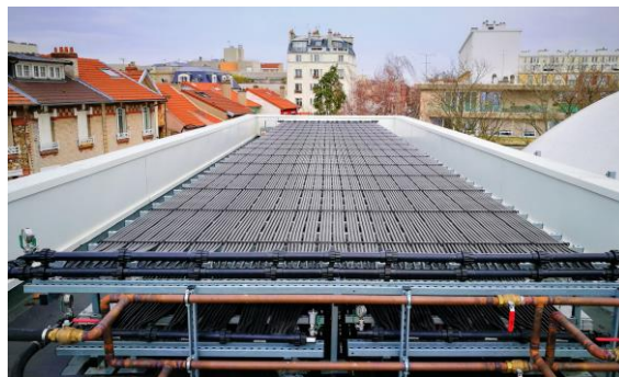
Pose superposée en toiture terrasse sur châssis métallique
