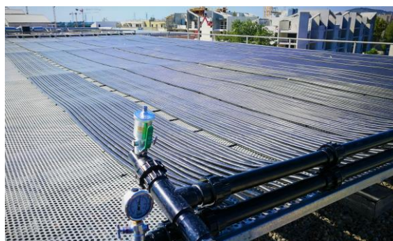
Pose en toiture terrasse sur caillebotis
