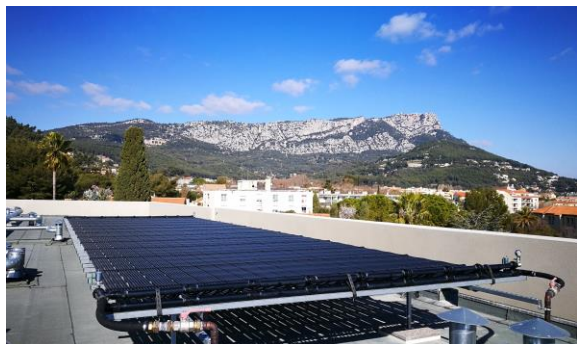
Pose en toiture terrasse sur châssis métallique
