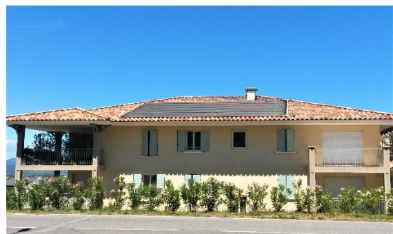
Pose sur toiture tuiles
